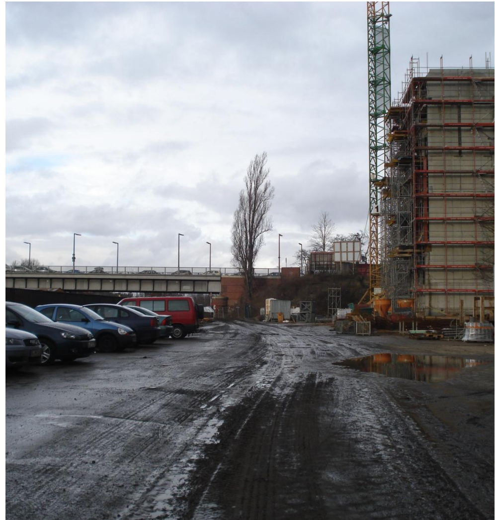
Blick Richtung Monumentenbrücke
