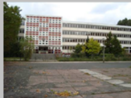
Rückbau Schule, Pankepark
