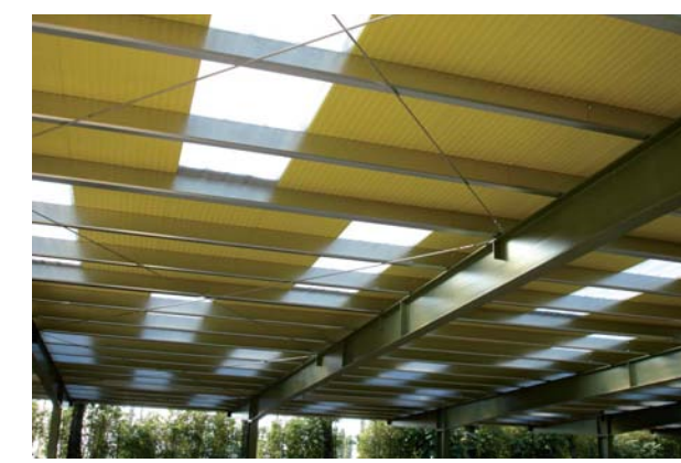
Lichtfelder im Dach
