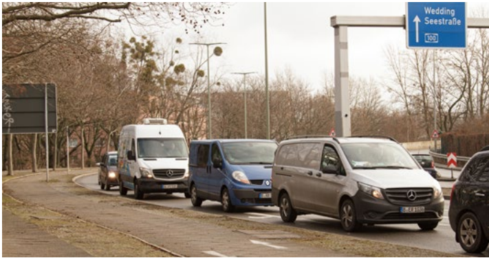
J.-Kaiser-Platz: 6 Fahrspuren für Autos, 1 gefährlicher Zwei-Richtungs-Radweg und 1 schmaler werdender Fußweg
