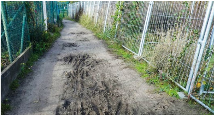
Derzeitiger Zustand am Spreeweg, Garten-Kolonie Schleusenland
