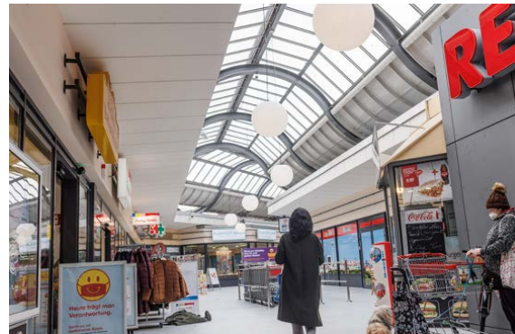
Im gesamten Einkaufszentrum wurde der Fußboden erneuert, Wände gestrichen und das Glasdach modernisiert. Alles wirkt heller und freundlicher.
