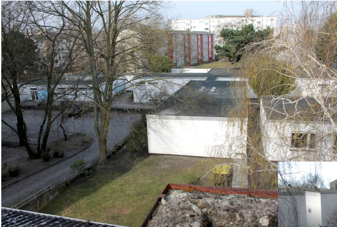
Blick vom Gemeindehaus über die Flachbauten (Zustand 2018)
