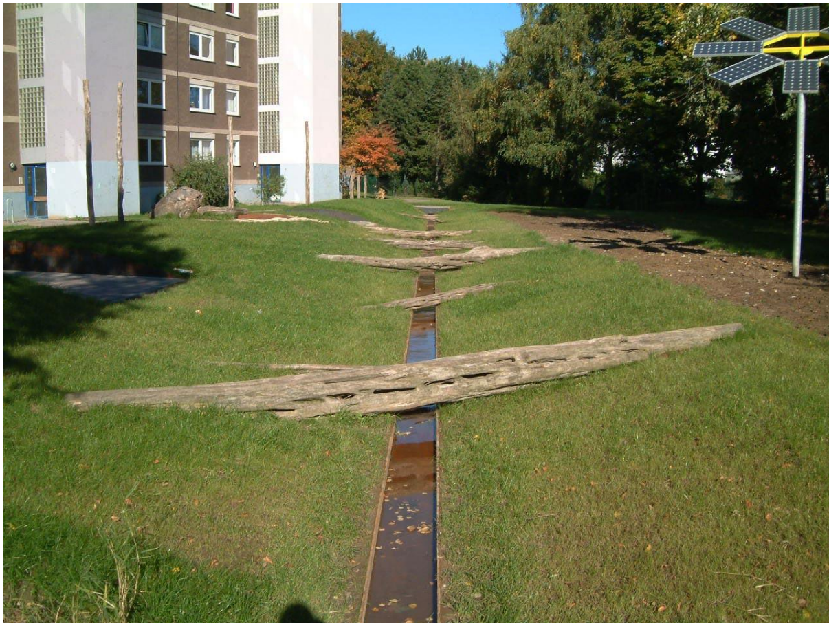
Abb. 33: Beispiel für dezentrale Regenwasserentwässerung
