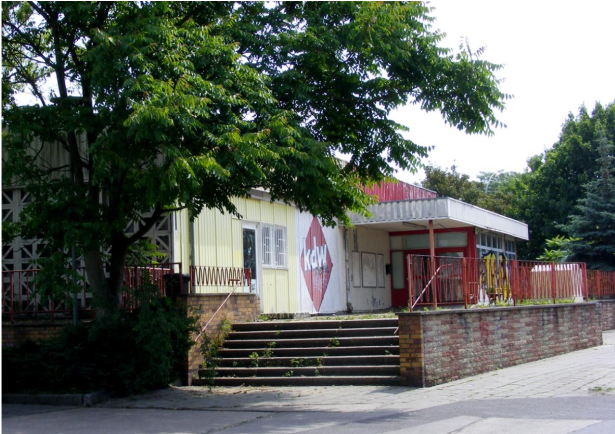
Abb. 26: Alte Kaufhalle, Hanns-Eisler-Str. 93
