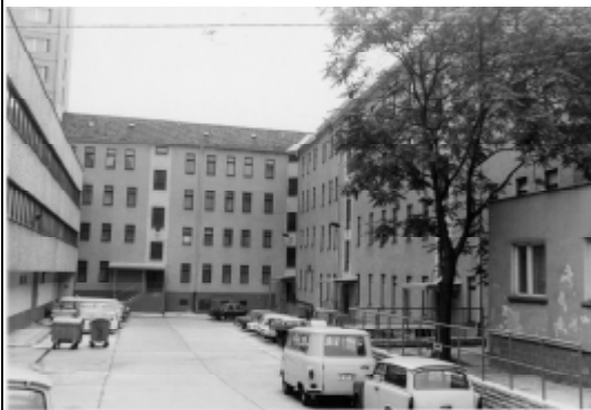
Hoffassaden Hof 9 von Westen BStU, MfS, BdL, Fo 29
