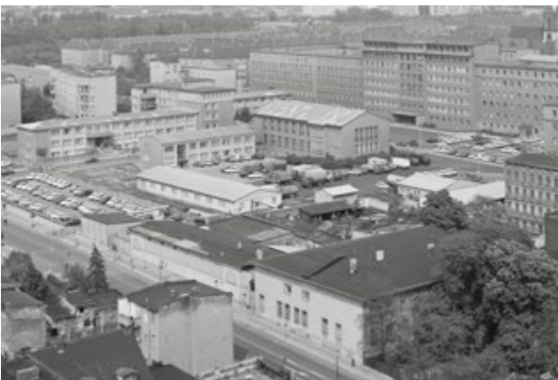
Abb. 39 Vogelschau von Südwesten in den frühen 1970er Jahren [BStU]
