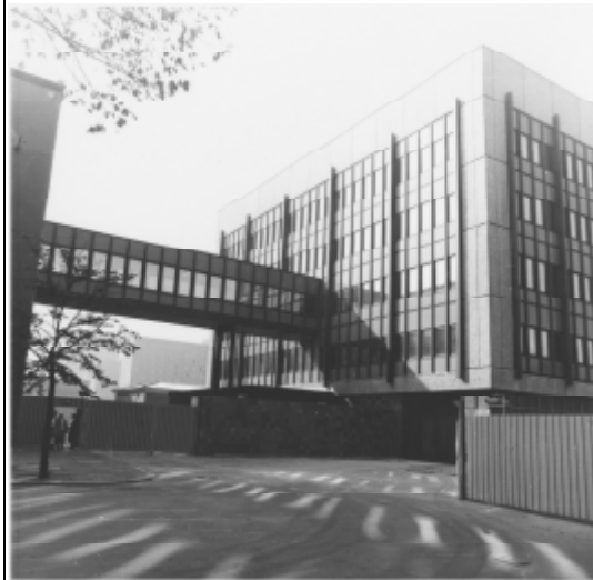
Brücke zwischen Haus 2 und Haus 18 MfS BdL Fo 291
