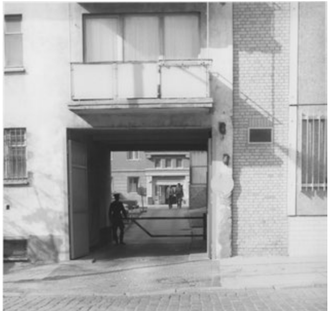
Abb. 95 Einfahrt von Haus 5 in der Achse des Durchgangs Haus 7 [BStU]
