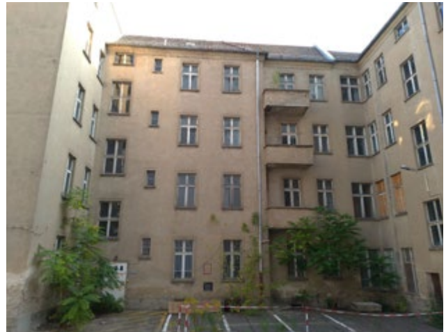
Abb. 42 Hof Haus 6 vor dem Abriss des Hauses
