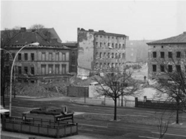
Abb. 60 Vorbereitung Abriss Bebauung an der Müllerstraße [BStU]
