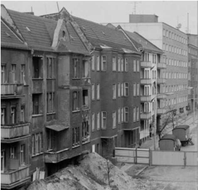
Abb. 94 Vorbereitung des Abrisses für den Neubau von Haus 8 an der Magdalenenstraße (Ausschnitt) [BStU]
