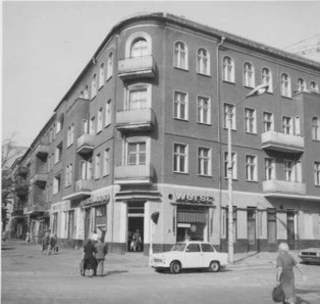
Abb. 72 Haus 12 mit Ladengeschäften und Wohnungen in den 1970er Jahren [BStU]
