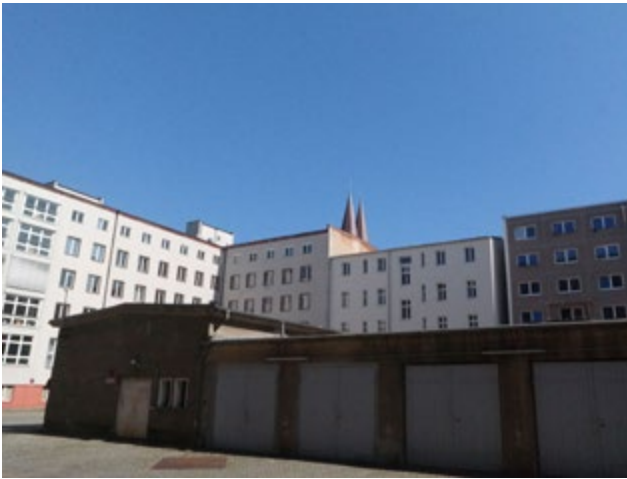
Abb. 47 Werkstatt und Garagengebäude
