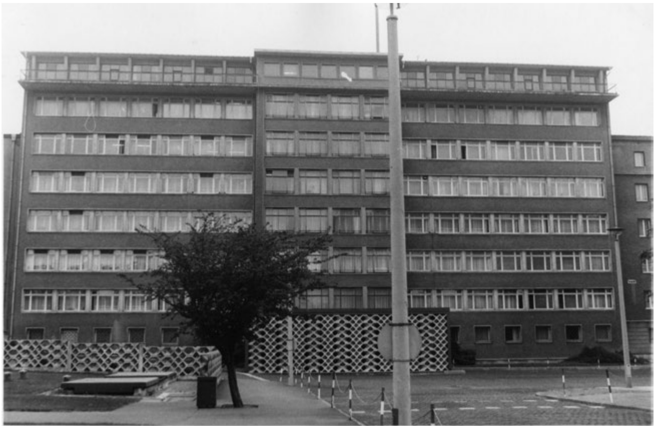
Abb. 13 Haus 1 von vorn, aus der Flucht vortretend und mit besonderer Höhenbetonung. 1980er Jahre [BStU]
