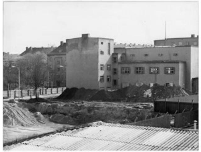
Abb. 90 Neuapostolische Kirche von Westen, im Vordergrund Baustelle Haus 18 [BStU]
