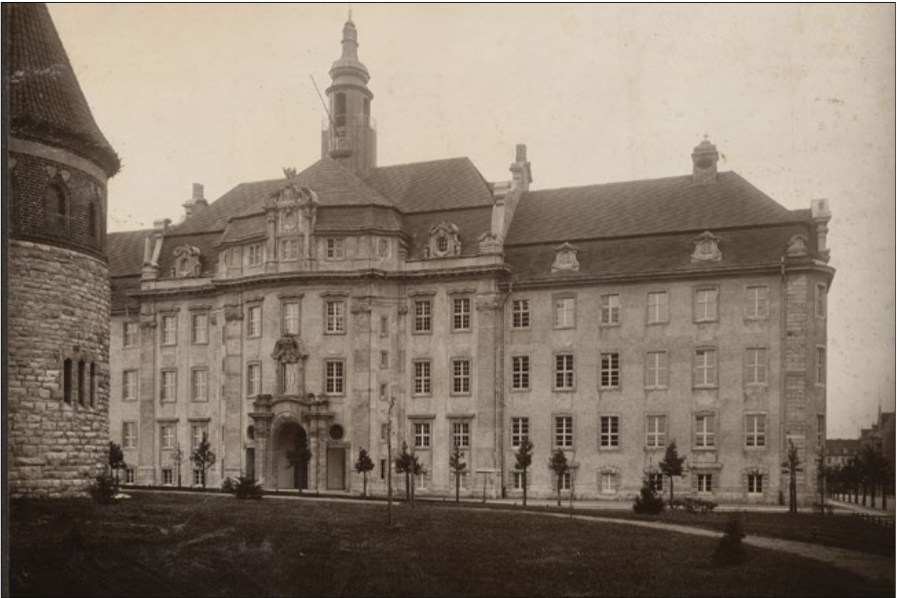
Abb. 6 Das Amtsgericht mit Blick nach Süden in die Magdalenenstraße (rechter Bildrand), ebenfalls 1907: Nur im Hintergrund sind Häuser unmittelbar an der Frankfurter Chaussee mit kaiserzeitlichem Fassadenschmuck und Dachlandschaft zu sehen. An der Magdalenenstraße stehen zu diesem Zeitpunkt nur die später als Haus 12 bezeichneten Gebäude [Architekturmuseum der TU Berlin]
