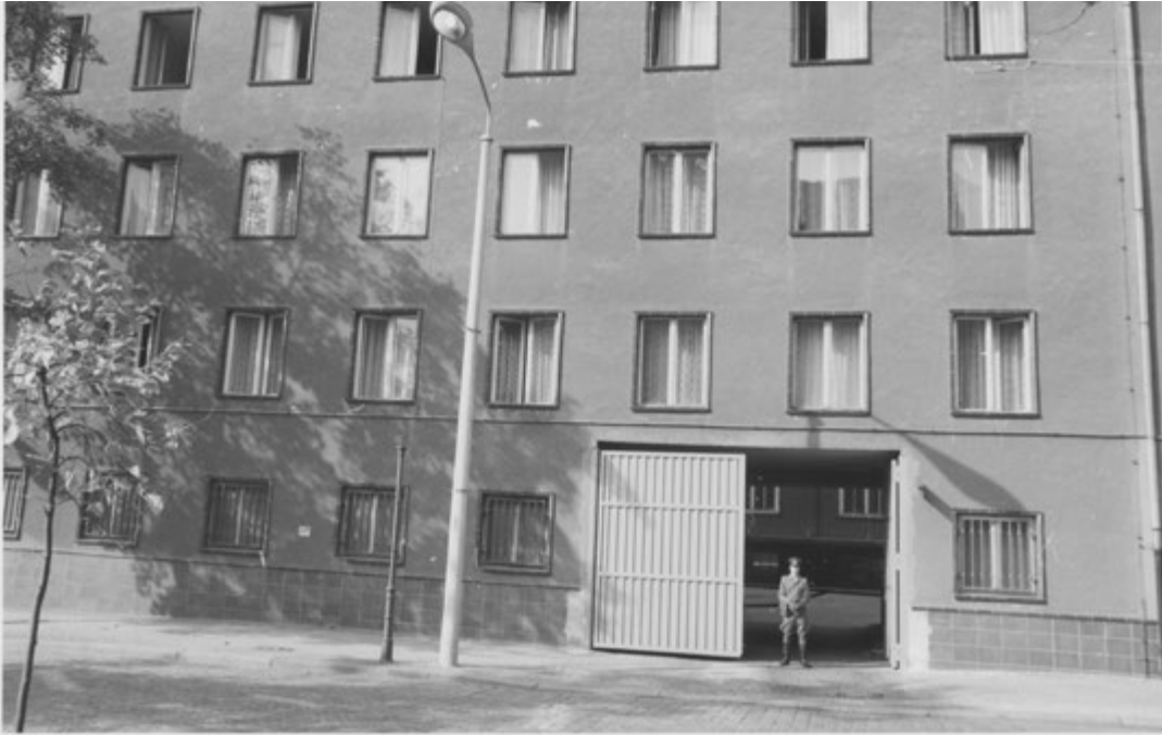
Abb. 15 Vergitterung und blickdichtes Tor am heutigen Finanzamtsgebäude, 1980er Jahre [BStU, Ausschnitt]
