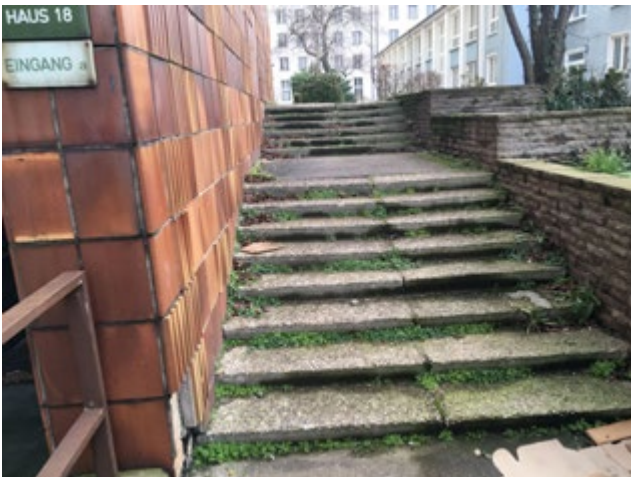
Abb. 68 Treppenanlage neben dem Südeingang / der Südeinfahrt zum Haus 18
