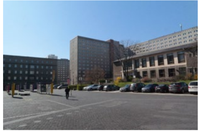
Abb. 34 Großflächig freier Raum im Hof 5
