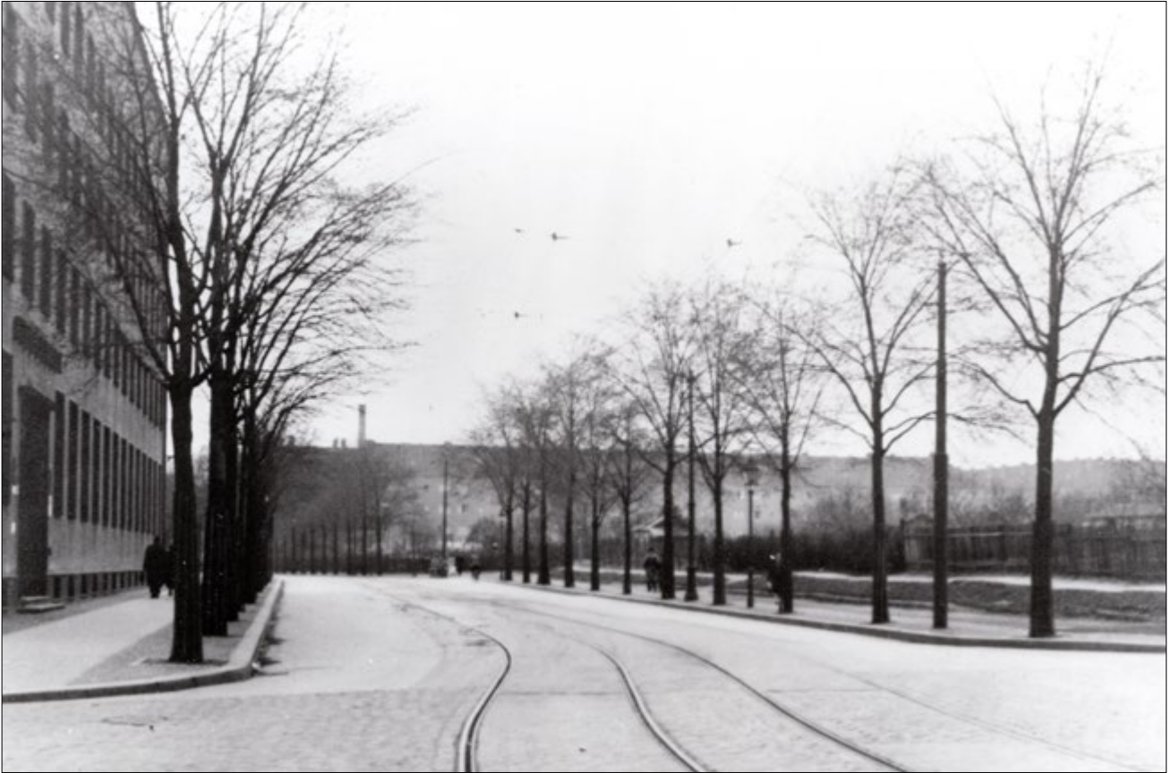
Abb. 11 Normannenstraße Blick Richtung Westen 1936. Links der erste Bauabschnitt des Finanzamtes, das 1938 in einem zweiten Bauabschnitt um mehrere Fensterachsen nach Westen erweitert wird [Landesarchiv]
