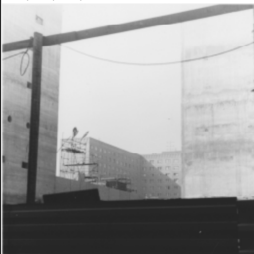
Stahlbetonkerne des Archivs während der Bauzeit, im Hintergrund Haus 15 BStU, MfS, BdL, Fo 291
