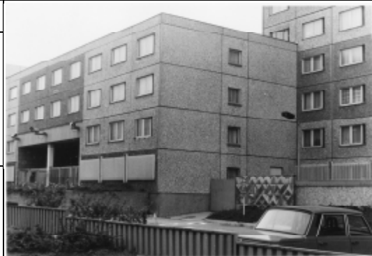
Überschobene Ecke mit Sichtschutzblende aus Betonformsteinen
