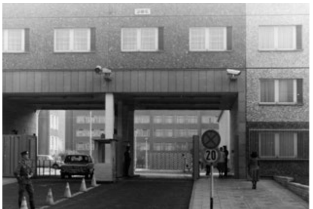
Abb. 40 Hauptzufahrt mit Blick in die zentrale Achse [BStU]
