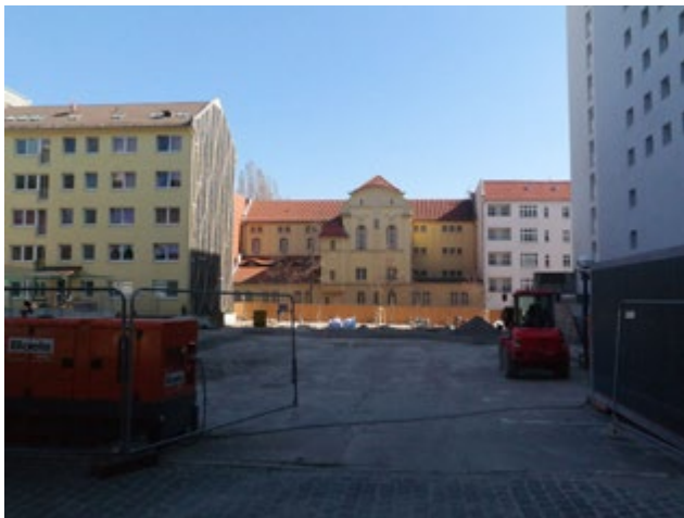
Abb. 43 Grundstück Haus 6 nach Beräumung, freier Blick auf das Gefängnis
