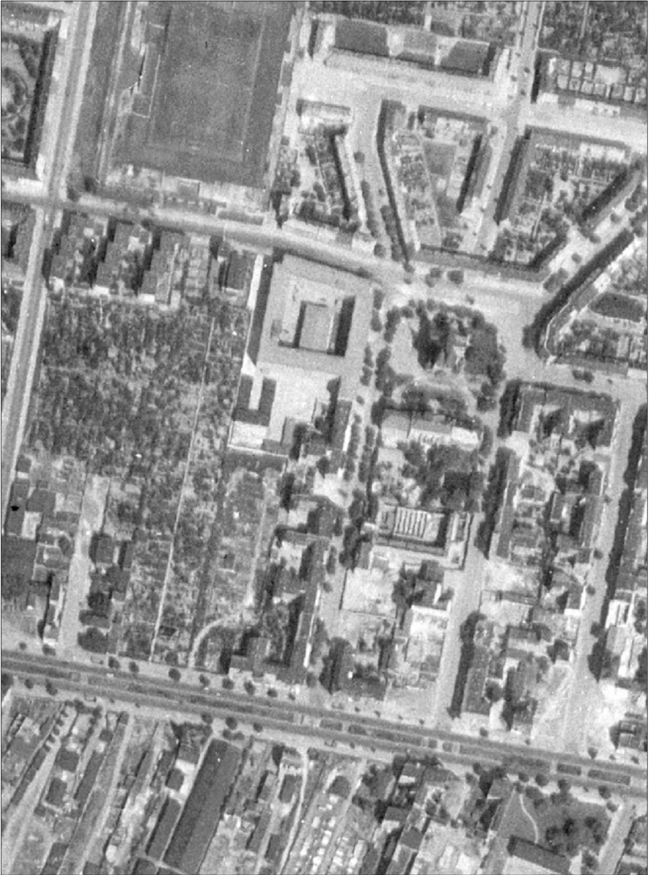
Abb. 28 Luftbild 1953, Erste Inanspruchnahme des Baublocks durch das MfS, Finanzamt bereits erweitert, weitere Gebäude im südlichen Anschluss. Bedeutung des Straßenzugs Normannenstraße durch fehlende Alleebäume nicht mehr klar erkennbar. Helmutstraße nur auf dem damaligen MfS-Gelände als Straßenoberfläche erkennbar. Kriegsbedingte Baulücke in der Magdalenenstraße (Standort Haus 5). [Quelle: Geodaten Berlin]
