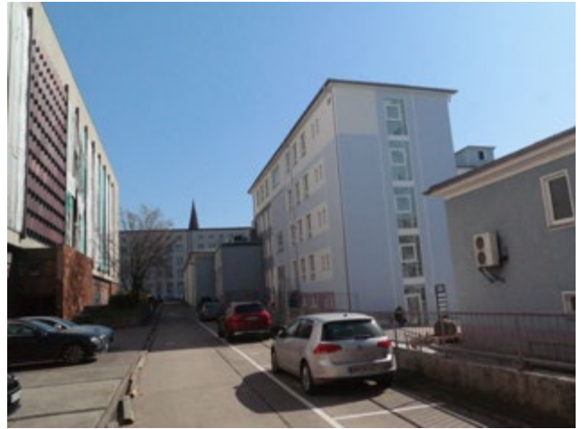
Abb. 71 Neubau Ärztezentrum Ruschestraße in Verlängerung Haus 19.3 von Nordwesten
