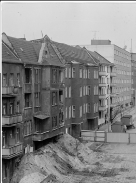
Vorgängerbauung vor der Sprengung (1980) BStU, MfS, VRD, Fo 41
