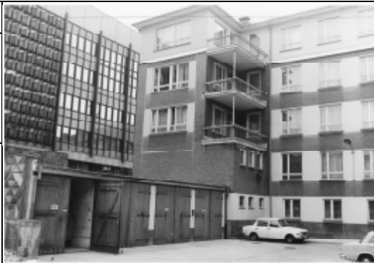
Hof des ZMD mit Garagenanlage BStU, MfS, BdL, Fo 29
