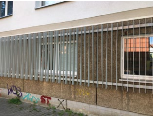
Abb. 92 Erdgeschosszone des Hauses 4 mit erhaltenem Gitter
