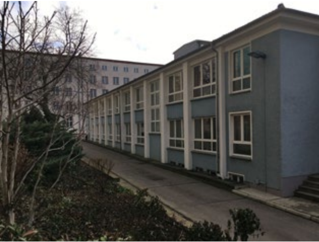
Abb. 70 Haus 20 von Nordwesten
