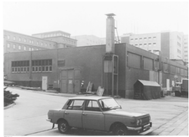
Abb. 58 Haus 26 von Südwesten, Südfront ggü. bauzeitlicher Fassung bereits vereinfacht. [BStU]
