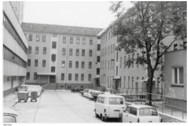
Abb. 56 Abschluss des Hofes 9, Haus 12 bereits umgebaut [BStU]
