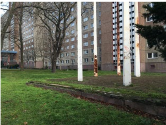
Abb. 21 Erhaltene Fahnenmastanlage an der Ecke Ruschestraße / Frankfurter Allee
