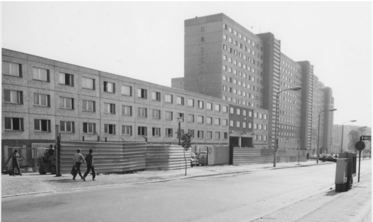
Abb. 82 Ruschestraßenbebauung von Nordwesten während der Errichtung von Haus 17 [BStU]
