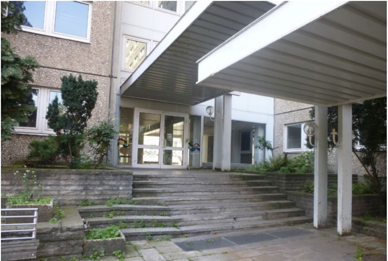
Abb. 65 Heutige Situation Eingang Haus 15.4 vom Hof 8 mit vollständig erhaltener bauzeitlichen Ausstattung
