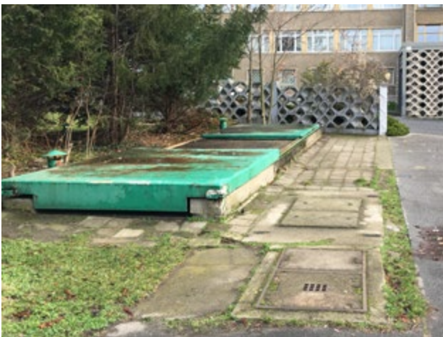
Abb. 23 Nur noch an einer Seite erhaltene Sichtblende aus Betonformsteinen am ehem. Waffenbunker vor Haus 1 / Haus 20, Situation 2020 von Westen aus gesehen
