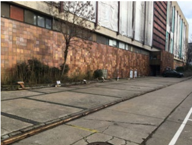
Abb. 66 Südseite Haus 18 von Südwesten
