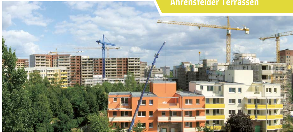
Baufortschritt „Ahrensfelder Terrassen“
