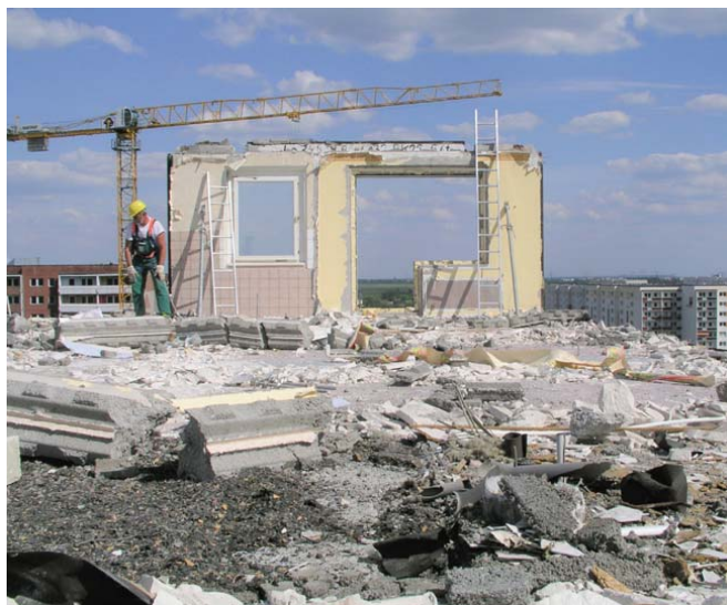
Rückbau Ahrensfelder Terrassen
