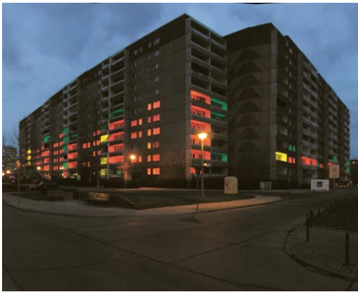
Lichtinstallation zur Erläuterung des Rückbaus
