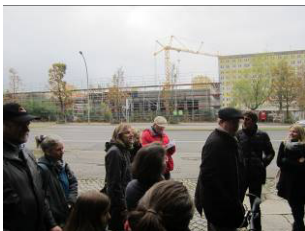
Im Bau befindliche Sporthallen gegenüber des Eingangs Kniprodestraße
