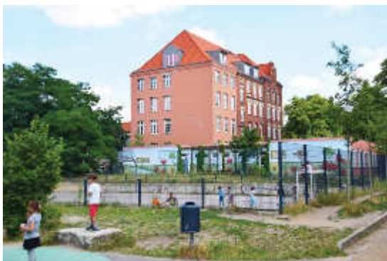
Grundschule am Birkenhain
