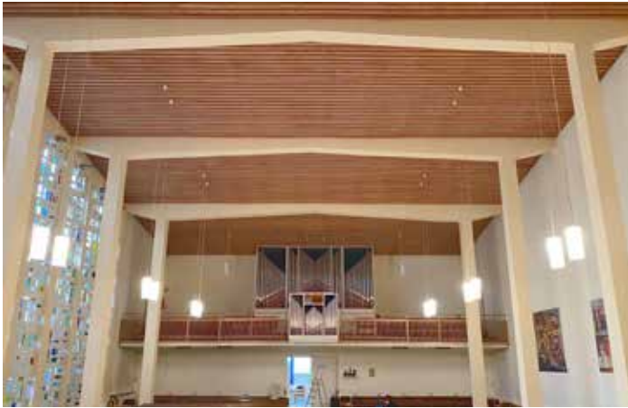
Betonskelett ohne reversible Verbindungen [Quelle: ZRS Architekten]
