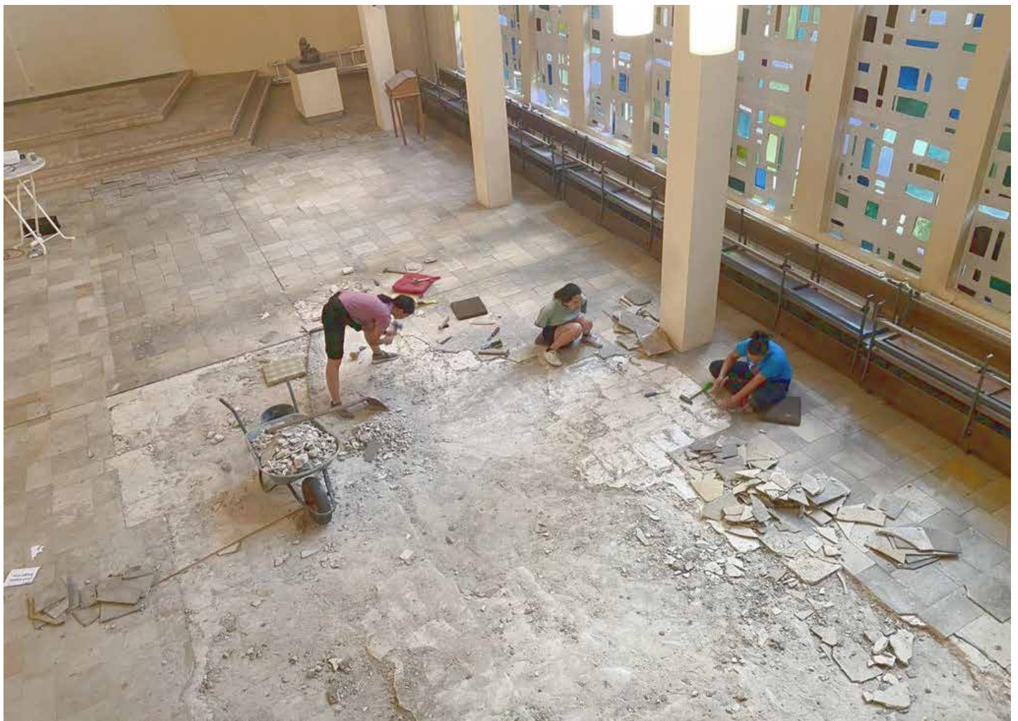
Freiwillige Helfer retten den hochwertigen Bodenbelag, um diesen im zukünftigen Begegnungszentrum wieder zu verwenden [Quelle: Ev. Kirchengemeinde]
