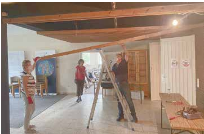
Demontage der Geschossdeckenverkleidung [Quelle: Ev. Kirchengemeinde]
