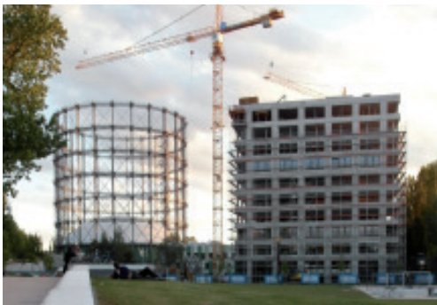
Baustelle Bürogebäude EUREF
