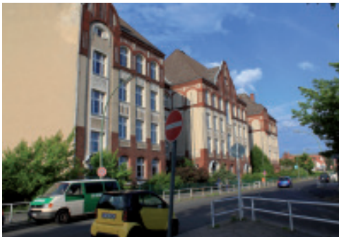
Luise und Wilhelm Teske Oberschule unter Denkmalschutz
