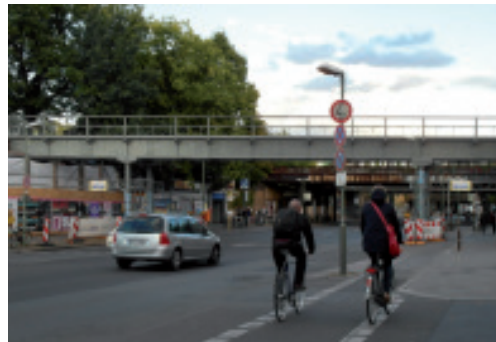
Yorckbrücke Nr. 5 saniert
