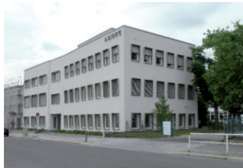
Gewerbe- und Büroräume Ambeg-Höfe
